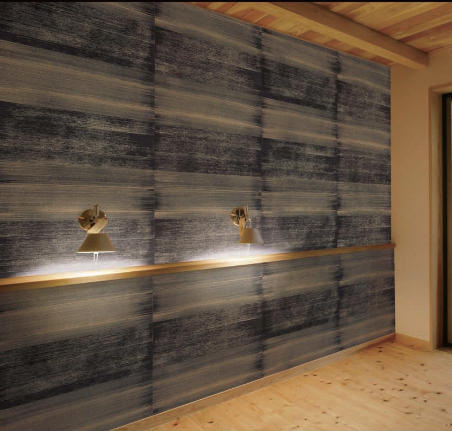
天地30cmにカットした3166と3167を組み合わせた施工例です。
