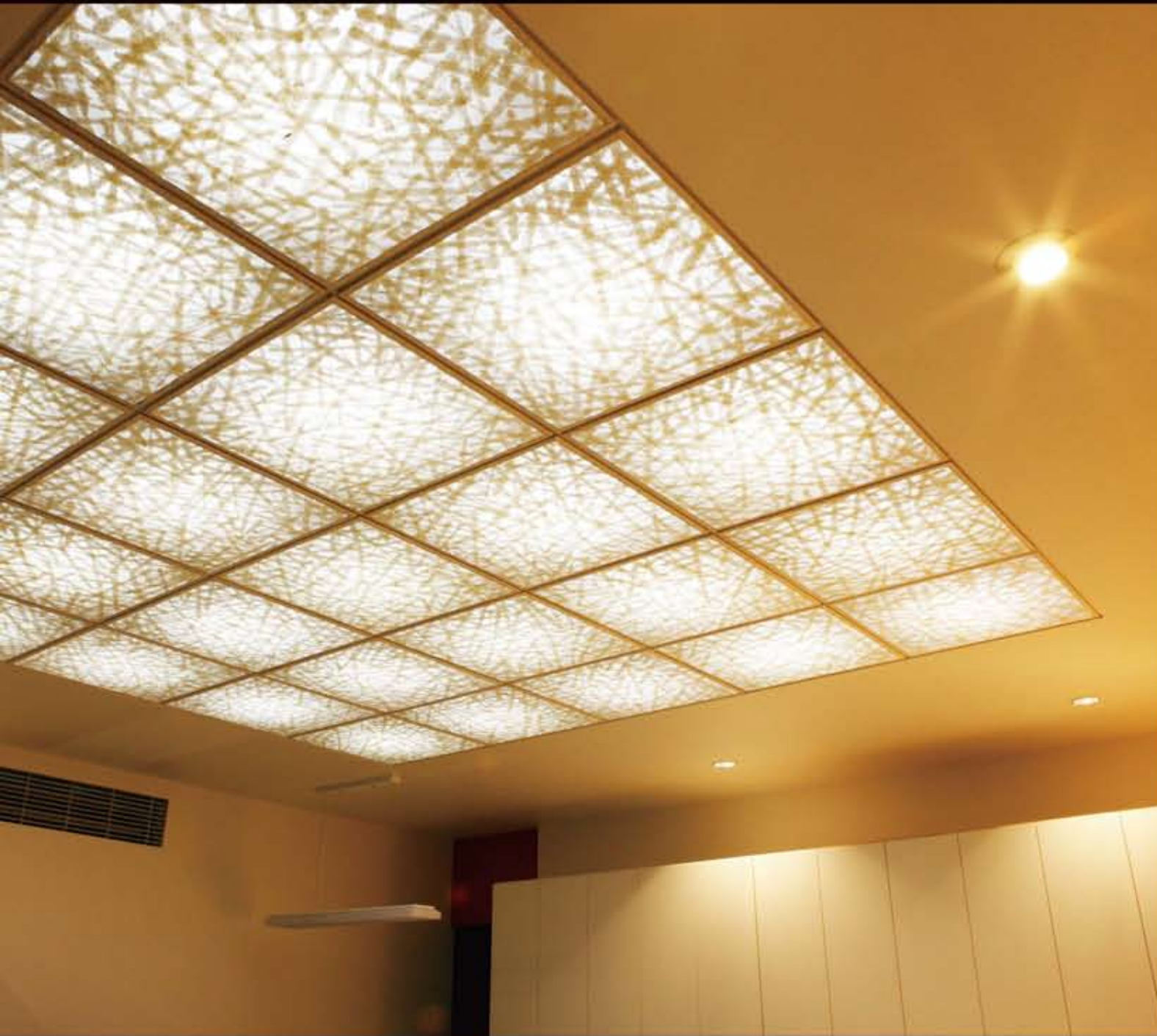
3301の施工例です。
